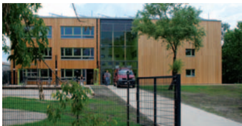
Die Photovoltaik-Anlage auf dem Dach der Kita produziert Sonnenstrom.
